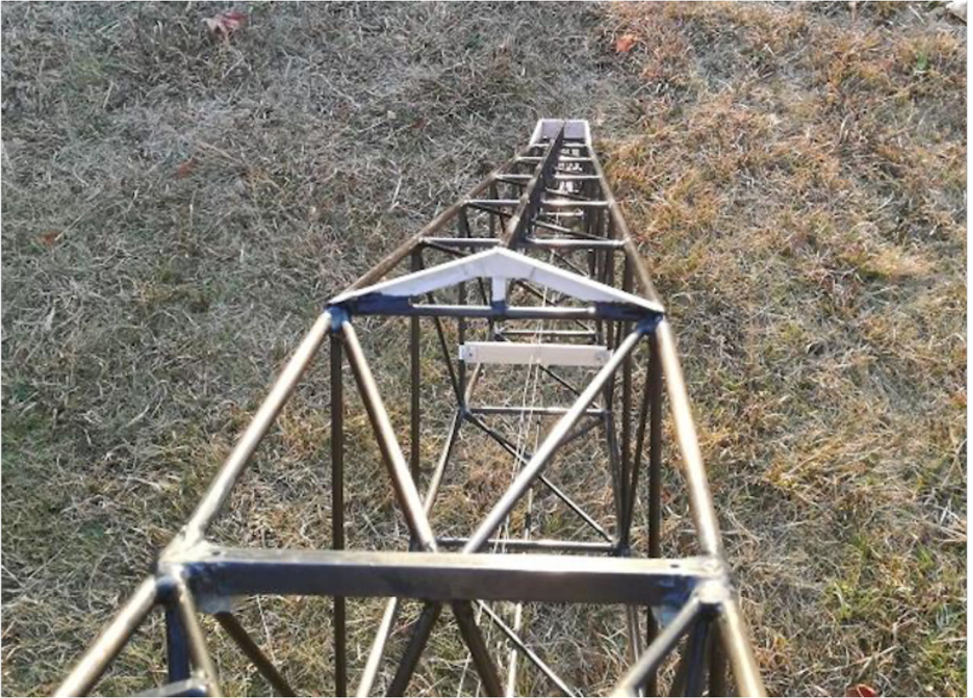
画像117 完成した胴体上部張出し構造
