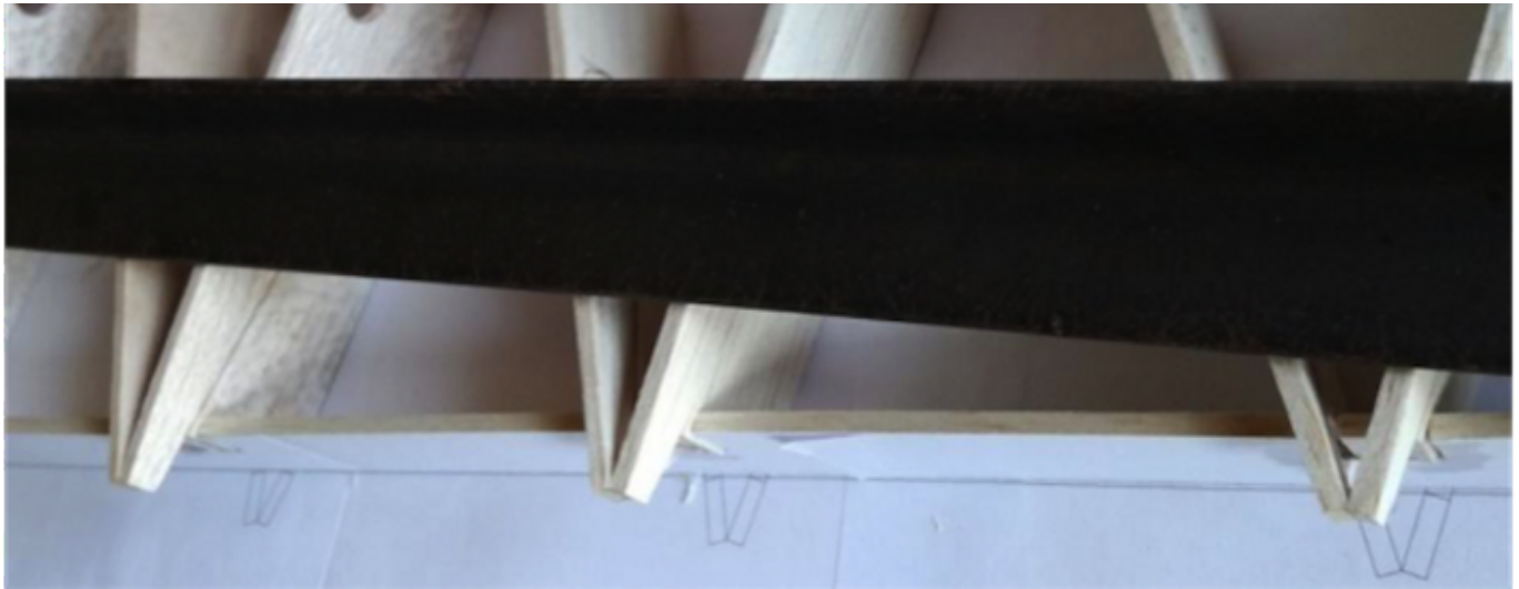
画像17 ラダーのリブ組み立て作業
