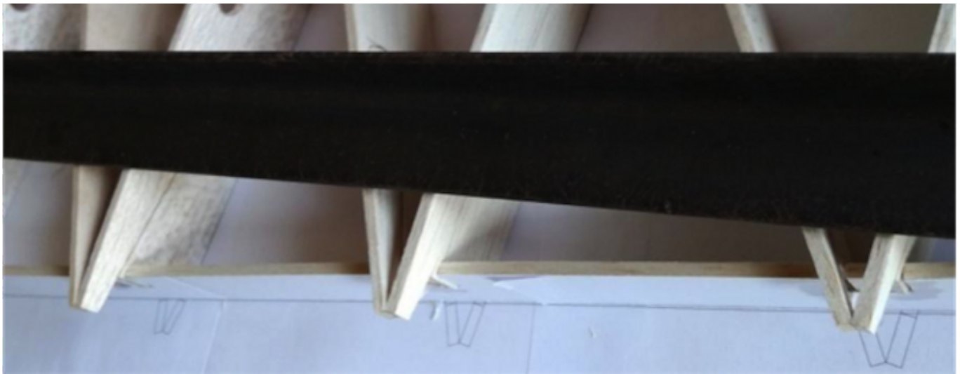
画像17 ラダーのリブ組み立て作業
